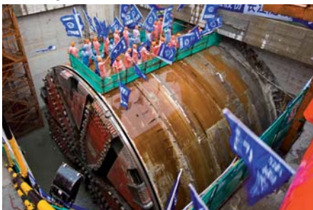
Durchbruch der derzeit weltweit größten Tunnelbohrmaschine bei der Yangtse-Unterquerung
